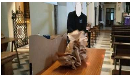
Iniziano i lavori nella chiesa di Santa Lucia
